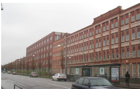
Fig. 13. C-, K- och A-fabrikernas fasader mot Artillerigatan.
