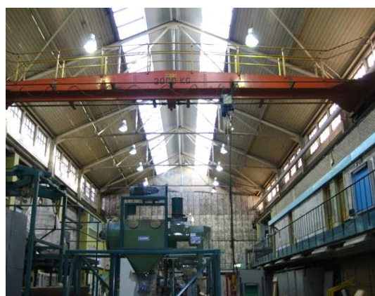
Fig. 18. M-verkstaden - interiör av verkstadshall med travers, entresolvåning, invändigt bärverk och överljus.
