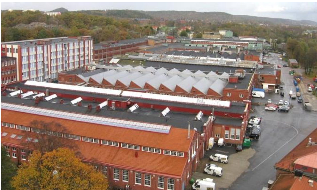
Fig. 12. Planområdet och dess taklandskap sett från SKF:s huvudkontor. I förgrunden M-verkstaden med två basilikaformade hallar, i mitten R-fabriken med sågtandstak. Högre byggnad till vänster är K-fabriken med Bunkeberget där bakom. Foto Lindholm Restaurering.
