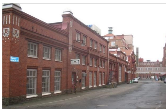
Fig. 15. M-verkstadens fasad mot Rullagergatan.
