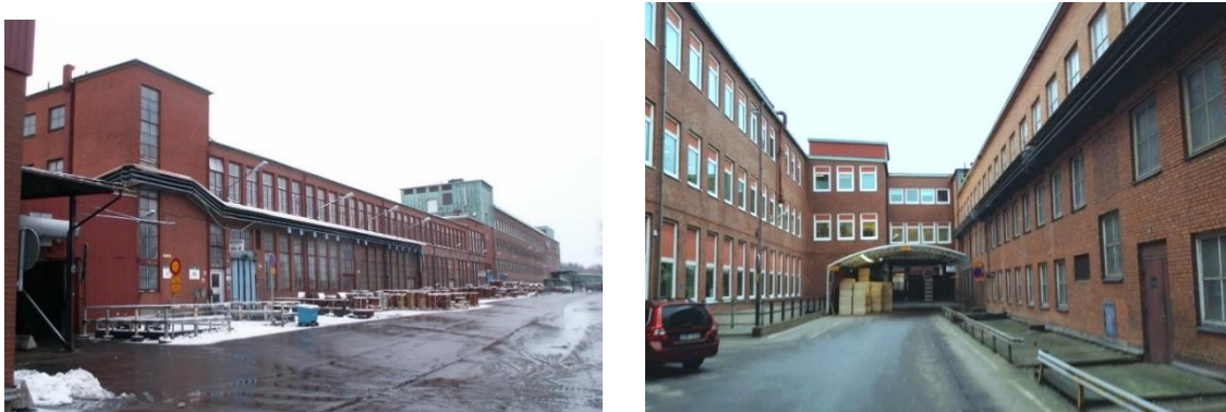
Fig. 22-23. Söderfasaderna utmed Kullagergatan i vy mot öster samt del av norrfasaderna till höger utmed Rullagergatan i vy mot öster.
